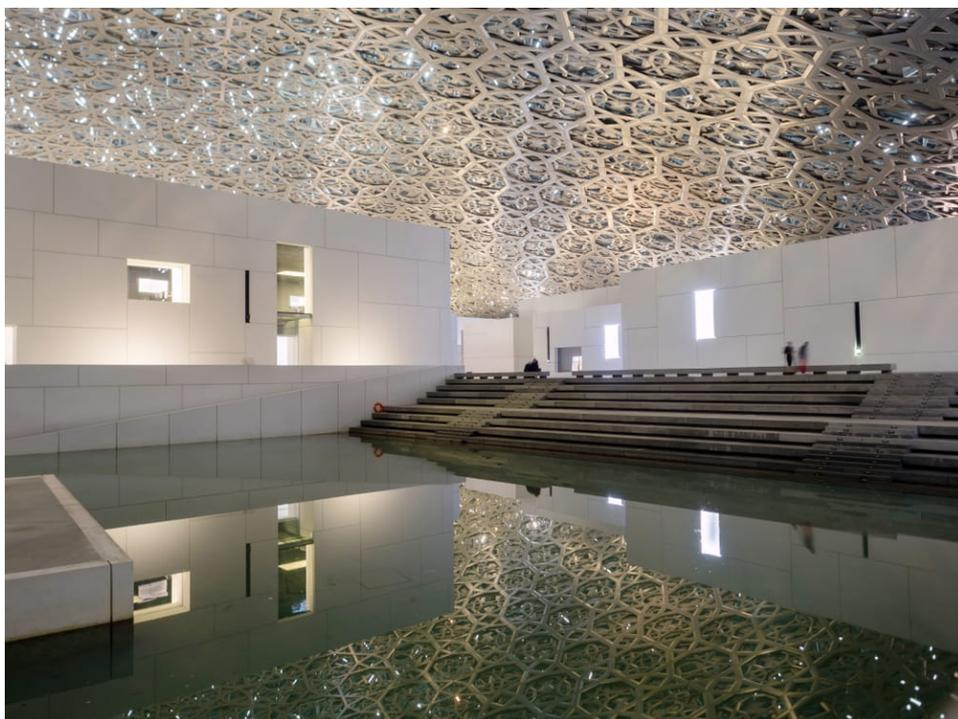
Эти звезды повторяются в разных размерах и под разными углами в восьми разных слоях. Четыре внешних слоя сделаны из нержавеющей стали, четыре внутренних слоя - из алюминия.
