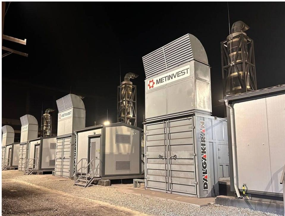
Підготовка інфраструктури для газопоршневих електростанцій охоплювала облаштування доріг, побудову бетонних майданчиків, встановлення трансформаторів, нового електричного обладнання, підведення газу, спорудження захисту від обстрілів. Додатково розосередили установки по території заводів, щоб між ними була дистанція. Але навряд чи росіяни витратять ракету за \$5 млн, щоб уразити установку за \$1,5 млн.
